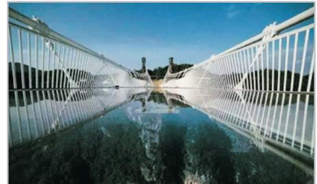
· 張家界大峽谷玻璃橋橋面長375米，寬6米，橋面鋪設99塊三層加疊的鋼化玻璃，橋面距谷底相對高度約300米，號稱是全球最長及最高玻璃橋，同時是全球首座大型橋樑以玻璃為主受力結構。雲天渡玻璃橋並創下了十項「世界之最」，並獲美國CNN列入世界上11座壯觀的橋之一。
